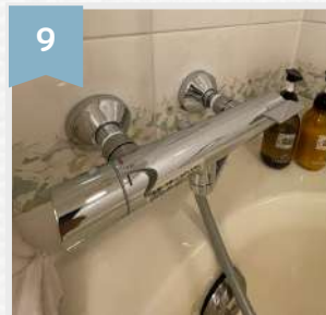
混合栓&湯温計設置
